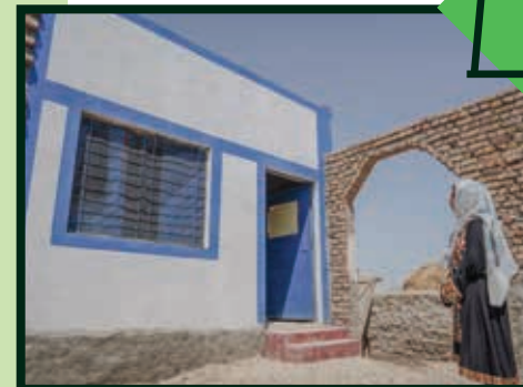
Après les inondations de 2023 qui ont touché le Pakistan, plusieurs familles ont reçu du matériel pour construire des abris plus durables, notamment de la pierre calcaire locale extrêmement résistante à l'eau.
